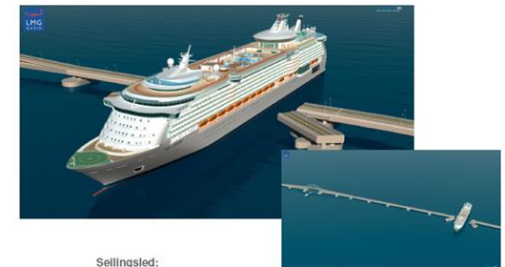
B: Flytebru m/ skipssluse
