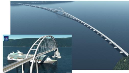
A: Flytebru med hogbru skipspassasje
